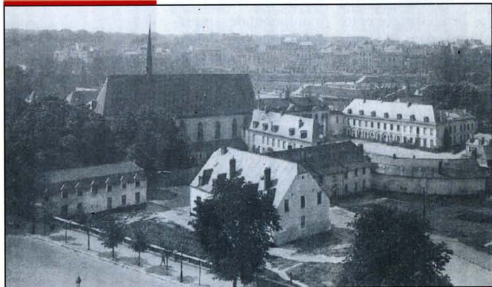
Vue panoramique de l'abbaye après la restauration (côté nord).
