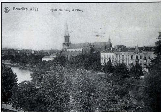
Sur cette vue des Étangs, on reconnaît face à l'église Sainte-Croix le bâtiment blanc de la guinguette du Casino.
