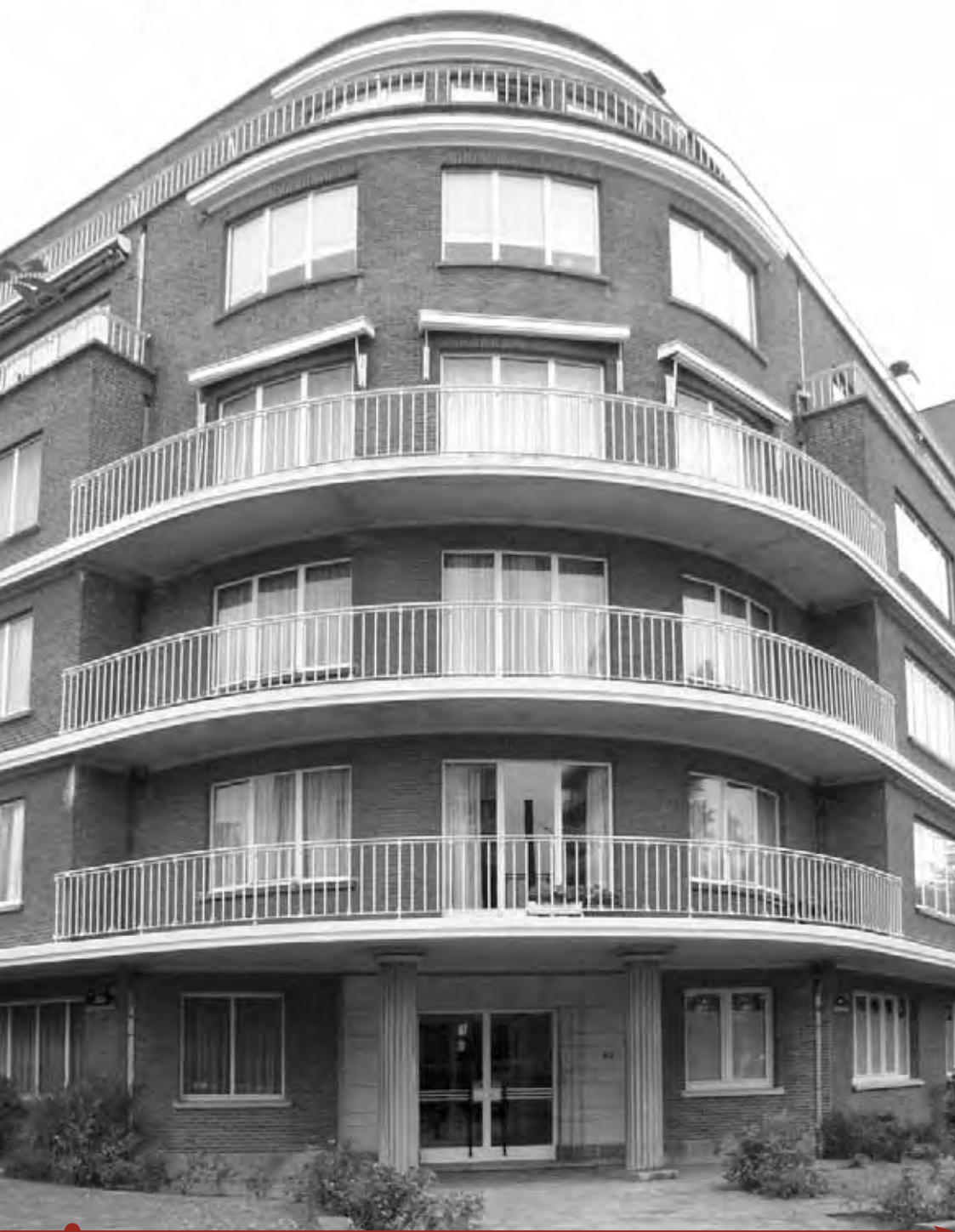
Immeuble à l'angle des Avenues du Derby et du Brésil
