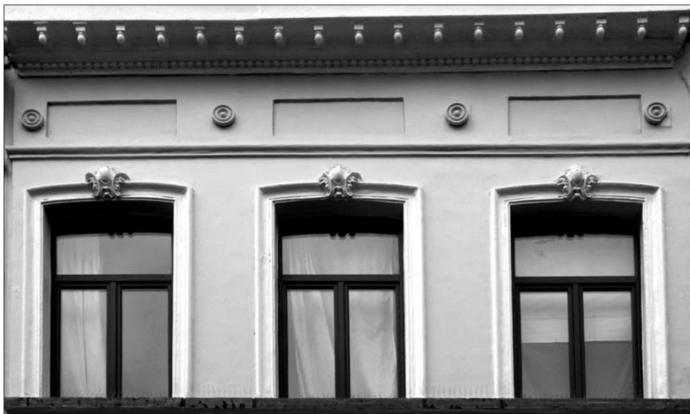
Restitution d'un châssis en bois rue Van Ellewijk
