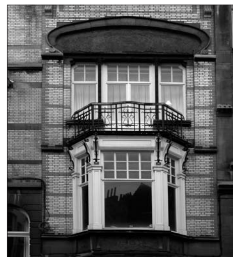
Restitution d'un châssis en bois rue Van Ellewijk
