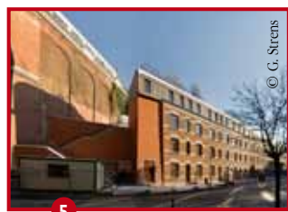
5 Création de 14 logements dont 2 pour PMR, rue Gray / Oprichting van 14 woningen waarvan 2 voor personen met beperkte mobiliteit, Graystraat
